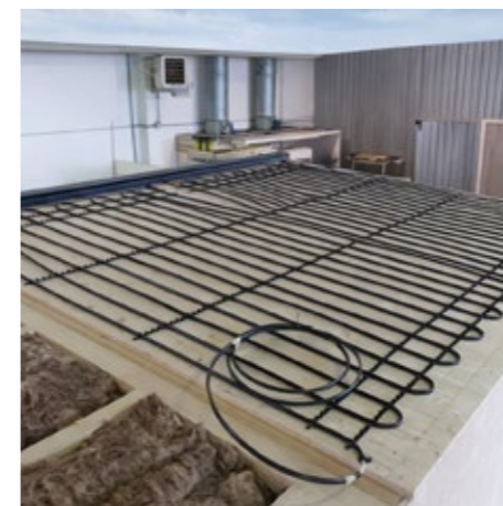
Tetto con rete riscaldata scioglineve e scioglighiaccio. Roof with heated snow-melting and ice-melting net.
